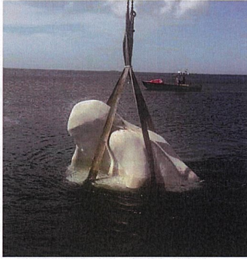
Yemaya a été transportée sur place grâce à un système de ballons sous pression.
