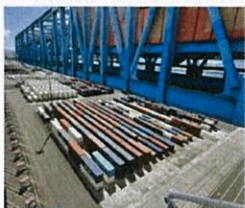
L'extension des quais prévue à terme d'accueillir 330 000 conteneurs. Cynthia Roussi-Sabas/Photo France-Antilles
